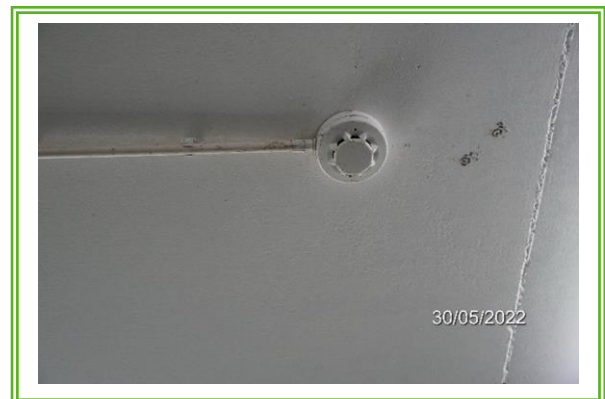
รูปที่ 3-25 เครื่องตรวจจับความร้อน (Heat Detector)
