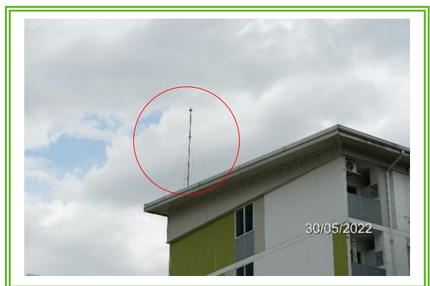
รูปที่ 3-31 เสาตัวนำล่อฟ้าบริเวณชั้นดาดฟ้าของ โครงการ
