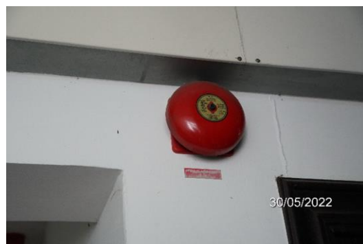
รูปที่ 2.5.9-2 อุปกรณ์ส่งสัญญาณแบบกริ่ง
