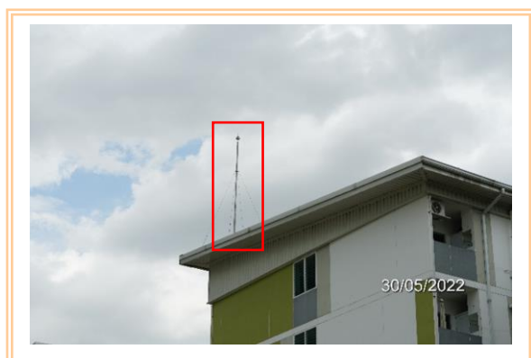
รูปที่ 2.5.9-11 เสาตัวนำล่อฟ้า
