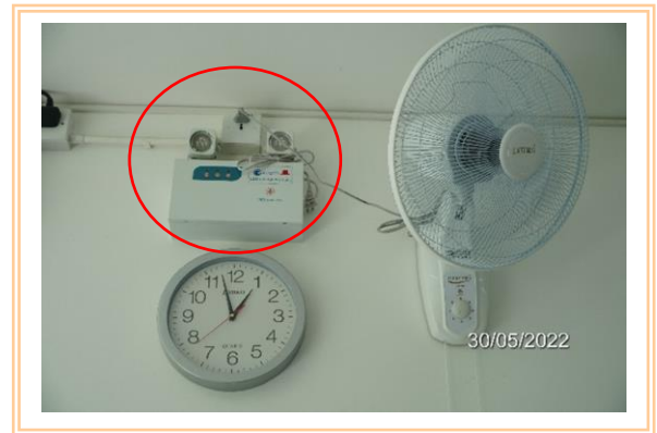
รูปที่ 2.5.9-8 ไฟส่องสว่างฉุกเฉิน
