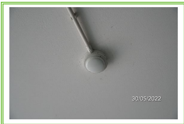
รูปที่ 3-24 เครื่องตรวจจับควัน (Smoke Detector)
