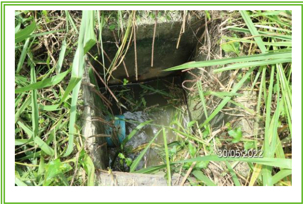
รูปที่ 3-11 ท่อรวบรวมน้ำทิ้งที่ผ่านการบำบัดก่อนระบาย ออกสู่ห้วยกรำ
