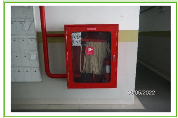
รูปที่ 3-27 ตู้เก็บสายฉีดน้ำดับเพลิง (Fire Hose Cabiner)
