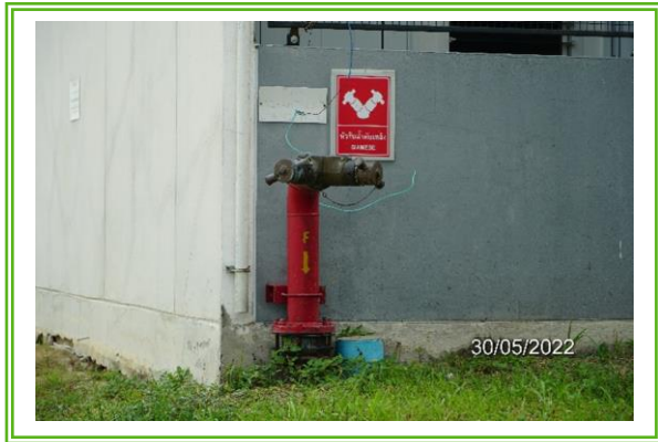
รูปที่ 3-26 ท่อรับน้ำดับเพลิง
