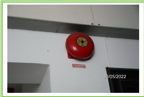
รูปที่ 3-22 สัญญาณแบบกริ่ง (Alarm Bell)
