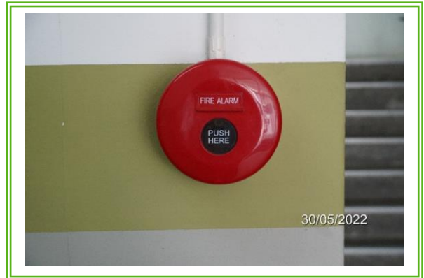
รูปที่ 3-23 ชุดกดแจ้งเหตุแบบใช้มือ (Manual Station)
