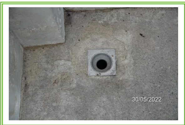
รูปที่ 3-17 ท่อระบายน้ำเสียจากการชะล้างห้องพัก มูลฝอย
