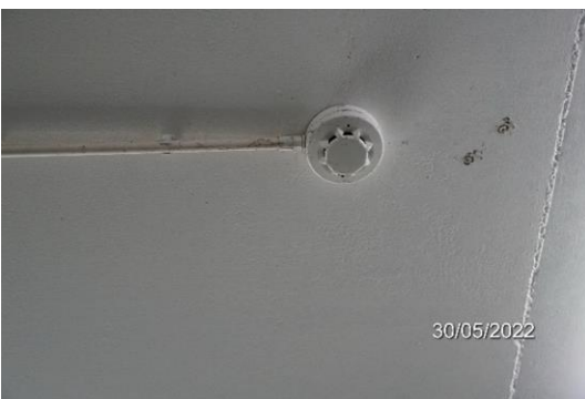
รูปที่ 2.5.9-4 อุปกรณ์ตรวจจับความร้อน
